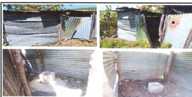
Foto 4: Sustitucion pared de letrina de lamina por blocks(letrinas).
