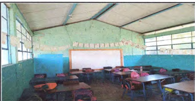
Foto 3: Cernido de paredes con monocapa interior y exterior del aula.
