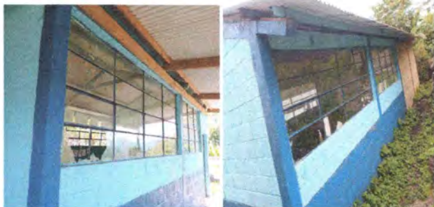
Foto1: Fabricacion e instalacion de balcones de metal
