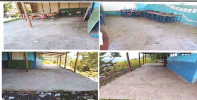
Foto 2: Instalacion de piso ceramico en el aula.
